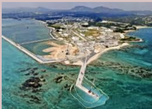
沖縄・辺野古 違法な工事でK8護岸を強行建設する政府
